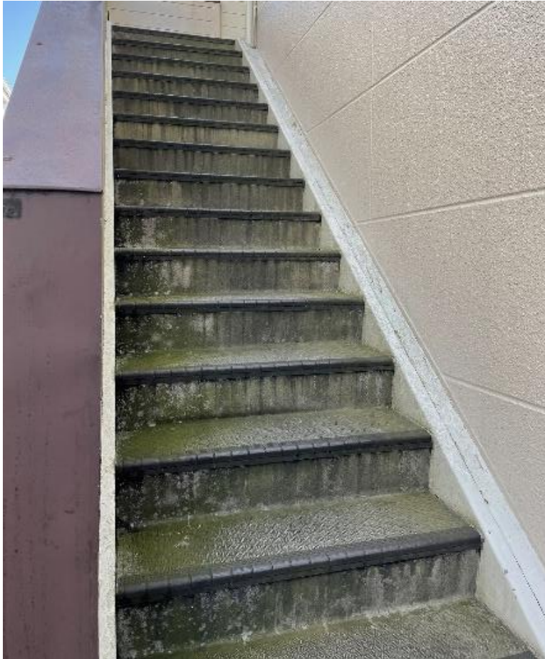
高圧洗浄も 積極実施
