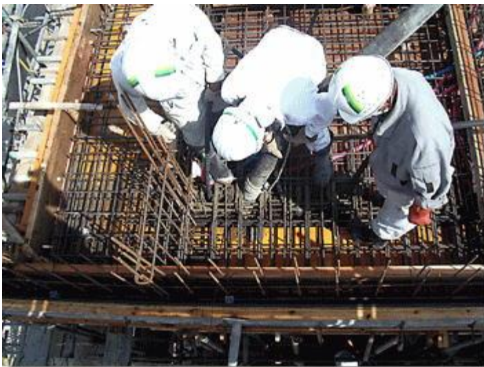
▲ 鉄筋の間にコンクリートが入っていくよう複数の人が突付きながら一気に作業
