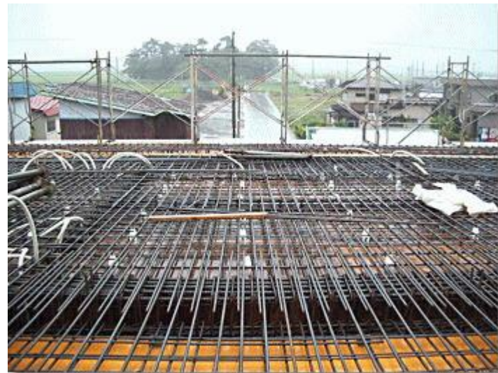
▲ 屋根用に組まれた鉄筋の様子
