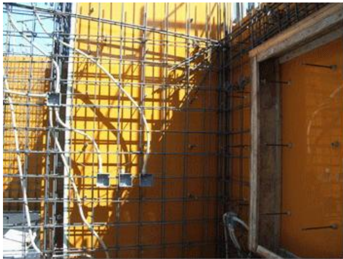
▲ 壁用に組まれた鉄筋の様子
