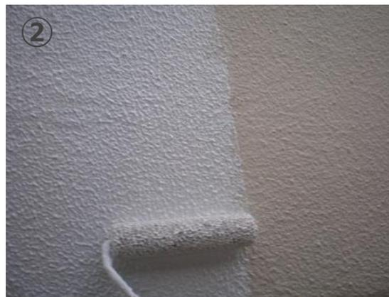
**(2) 外壁調整・爆裂・欠損補修** (欠損補修 爆裂補修 コンクリート打放・外壁・屋根下地調整)
