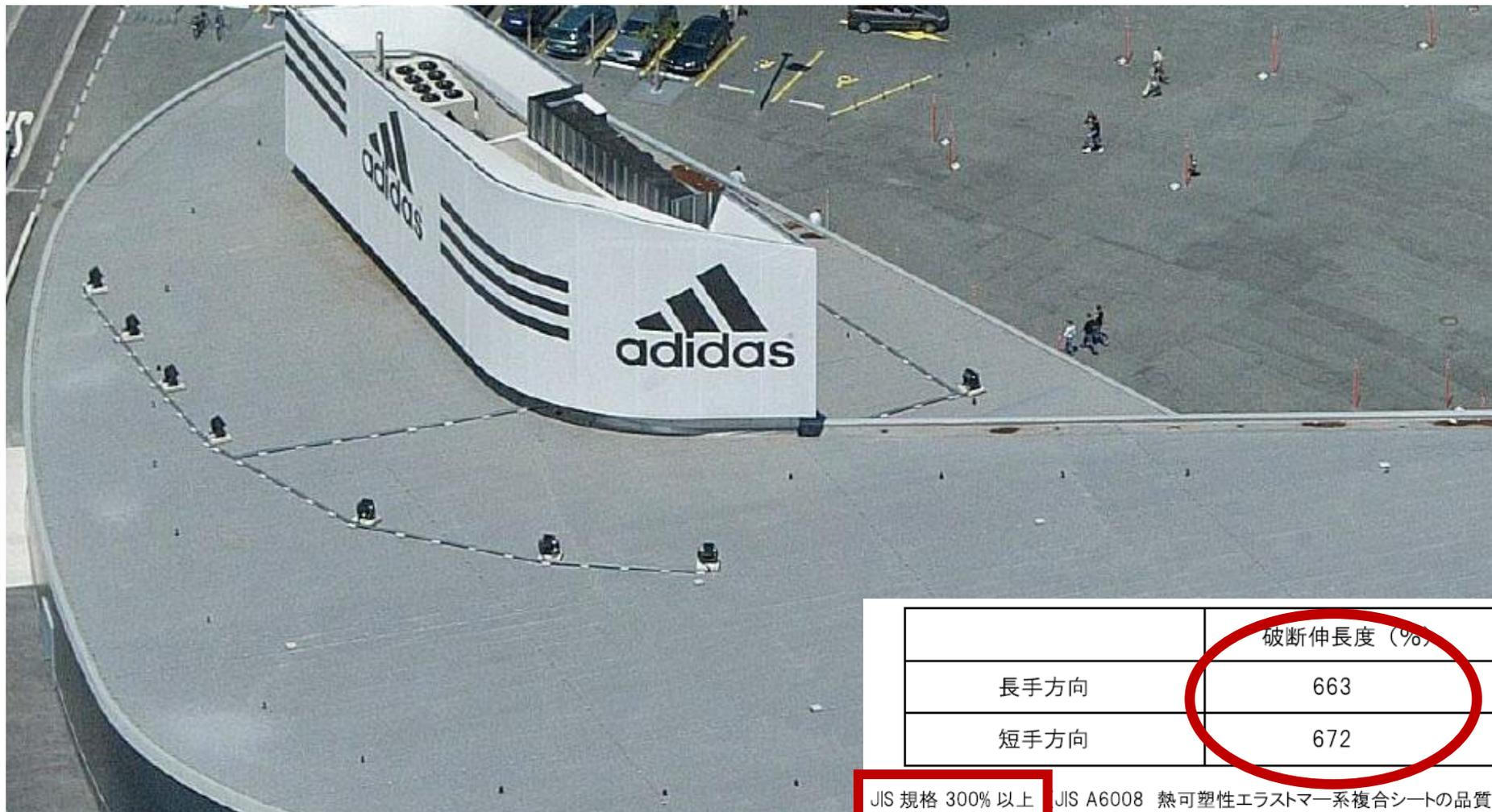
JIS 規格 300% 以上 JIS A6008 熱可塑性エラストマー系複合シートの品質)
