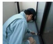
「外部（バルコニー）」調査の様子
