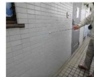
「外部（外壁）」調査の様子
