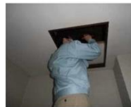
「小屋組・梁」調査の様子
