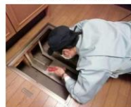
「土台・床組、基礎」調査の様子
